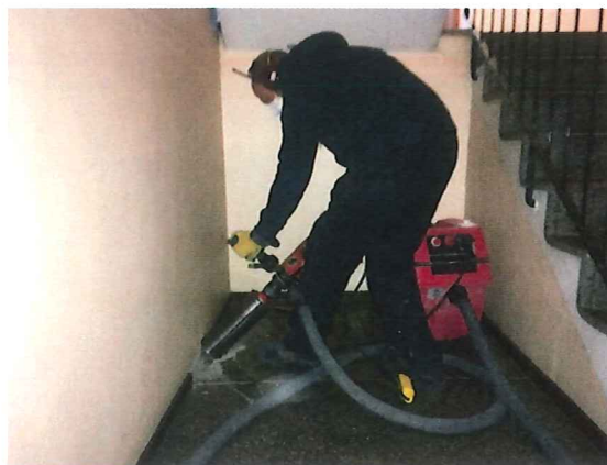
På bilden borrar ingång under bottenplattan för radonsugfläkt.
