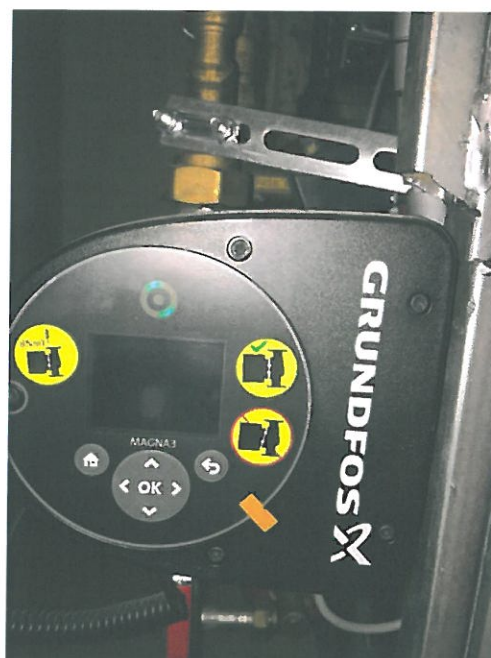
Figur 6. Cirkulationspump till VV, frekvensstyrning.
