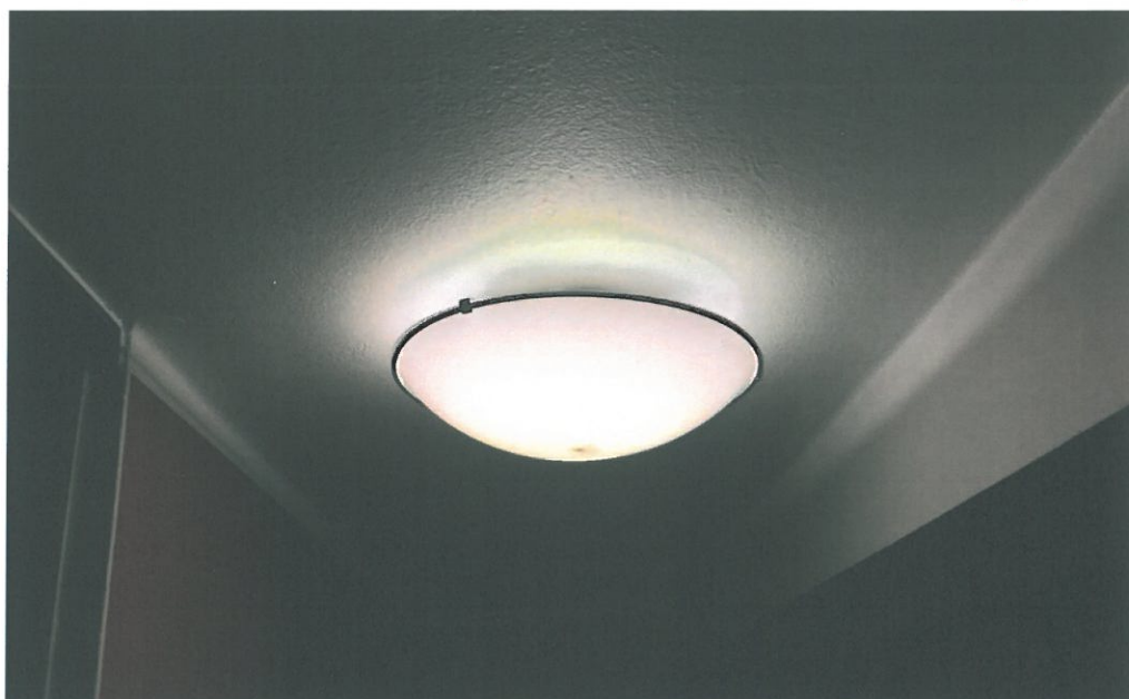
Figur 10. Belysning i trapphus, dygnet runt/året om-drift.
