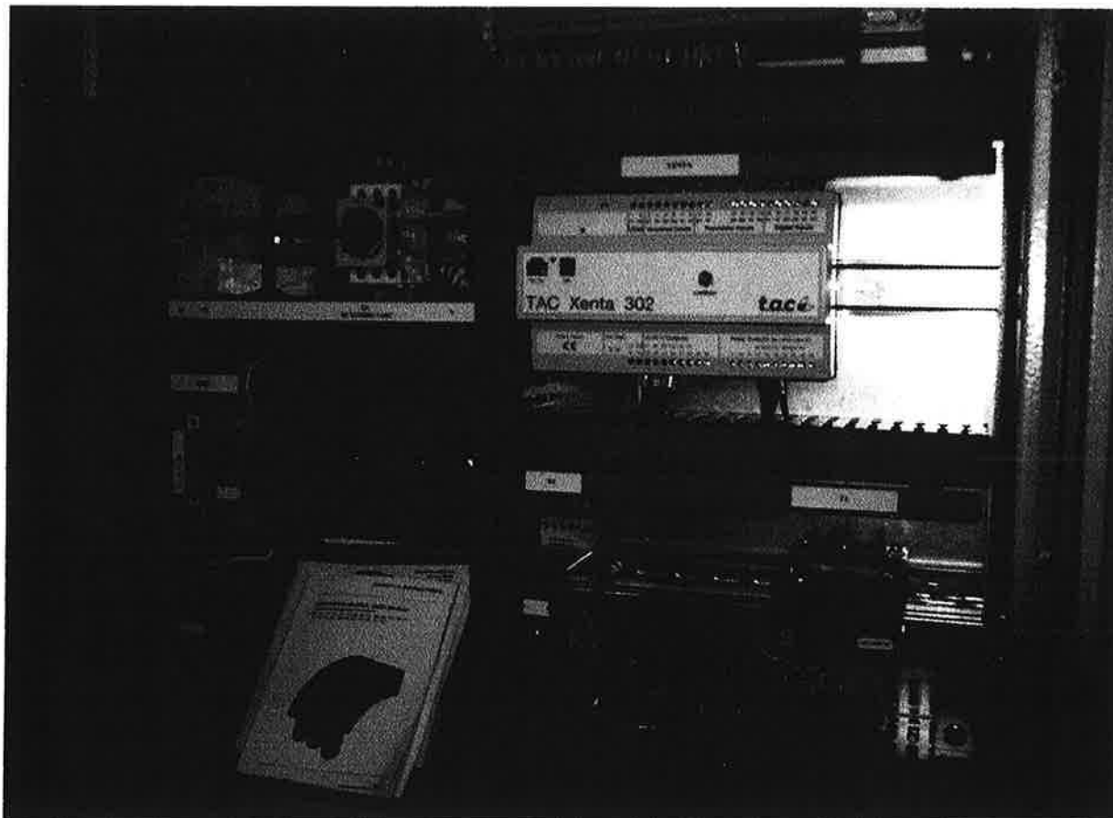
Reglercentral som sköter framledningstemperaturen och varmvattnet i byggnaden.
