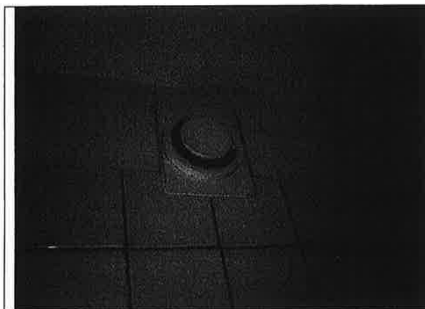
Frånluftsdon i badrum.
