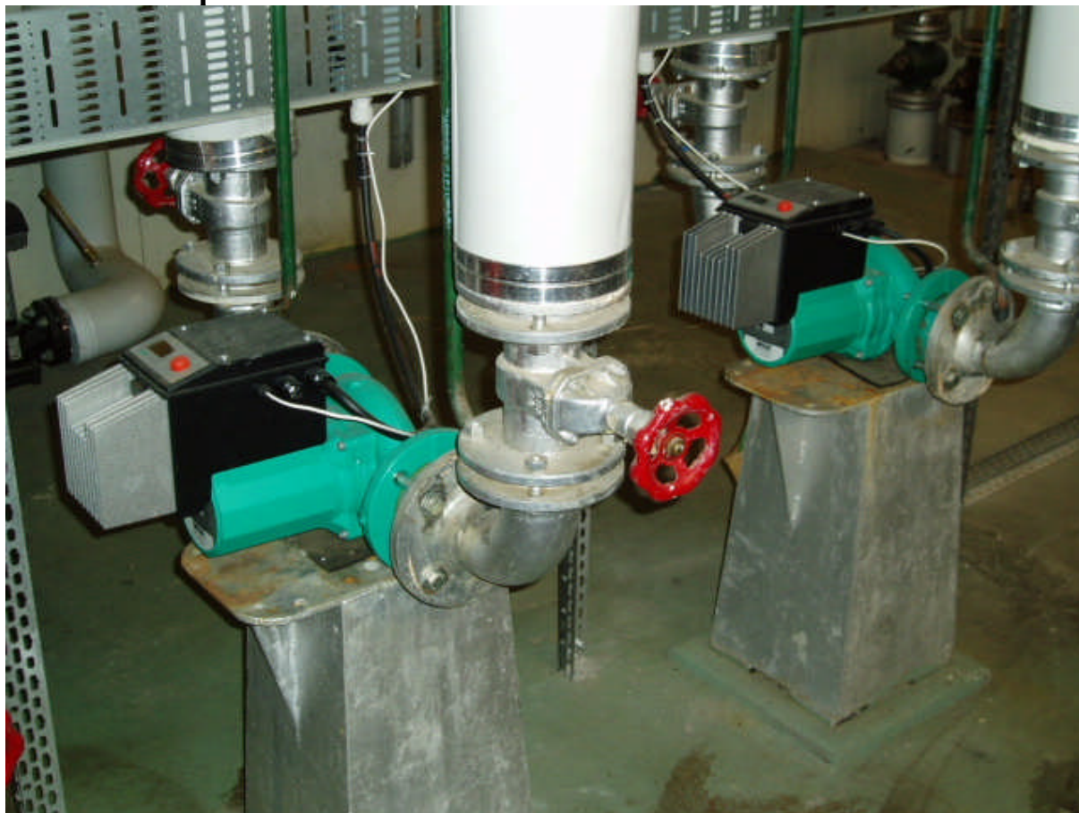
Cirkulationspumpar för värmen.
