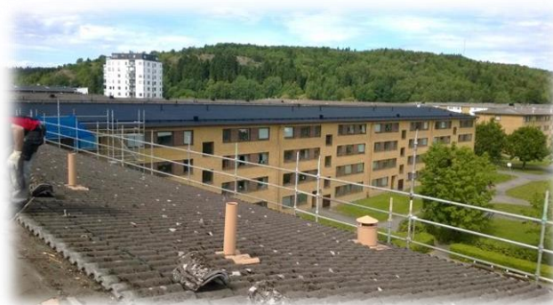
Bild från takomläggningen 2014
