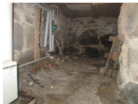
Överblick källaredel Smålandsgatan 19
