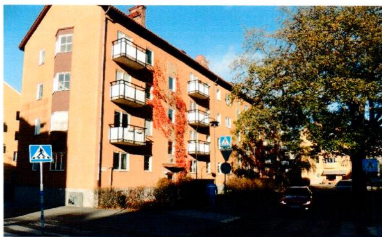
Föreningens fastigheter: Manhemsgatan 5 – 9, Hägerstenvägen 146 – 156 samt Vapengatan 3 – 11
